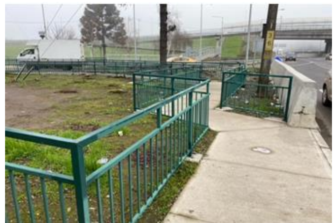
Vallas Peatonales en Enlace Cocharcas (Km 391,970)
