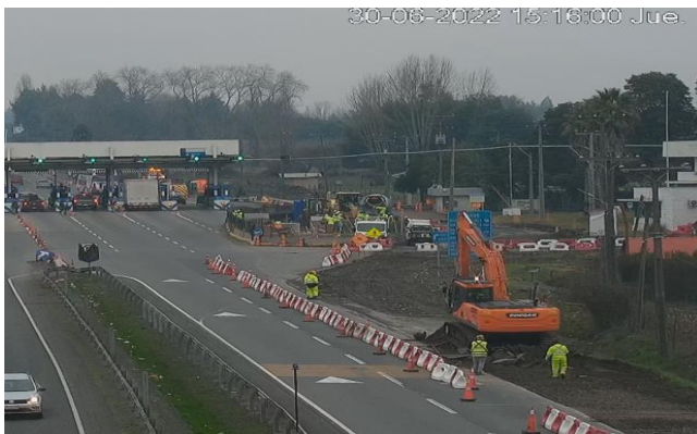
Obras Sistema de Cobro Mixto en Peaje Retiro (Km 322,560)
