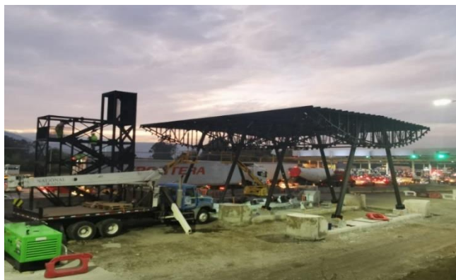
Obras Sistema de Cobro Mixto en Peaje Río Claro (Km 220,330)
